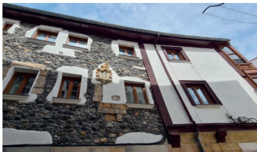
Restauración de Fachadas en Ardigales
