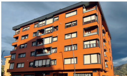
Rehabilitación de fachada ventilada
